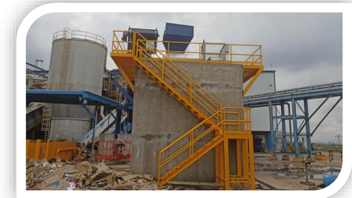
ESCALERA DE ACCESO, INSTALACIÓN DE BARANDALES Y ELECTROMECAÁNICA PARA PRENSA EXTRUSORA
